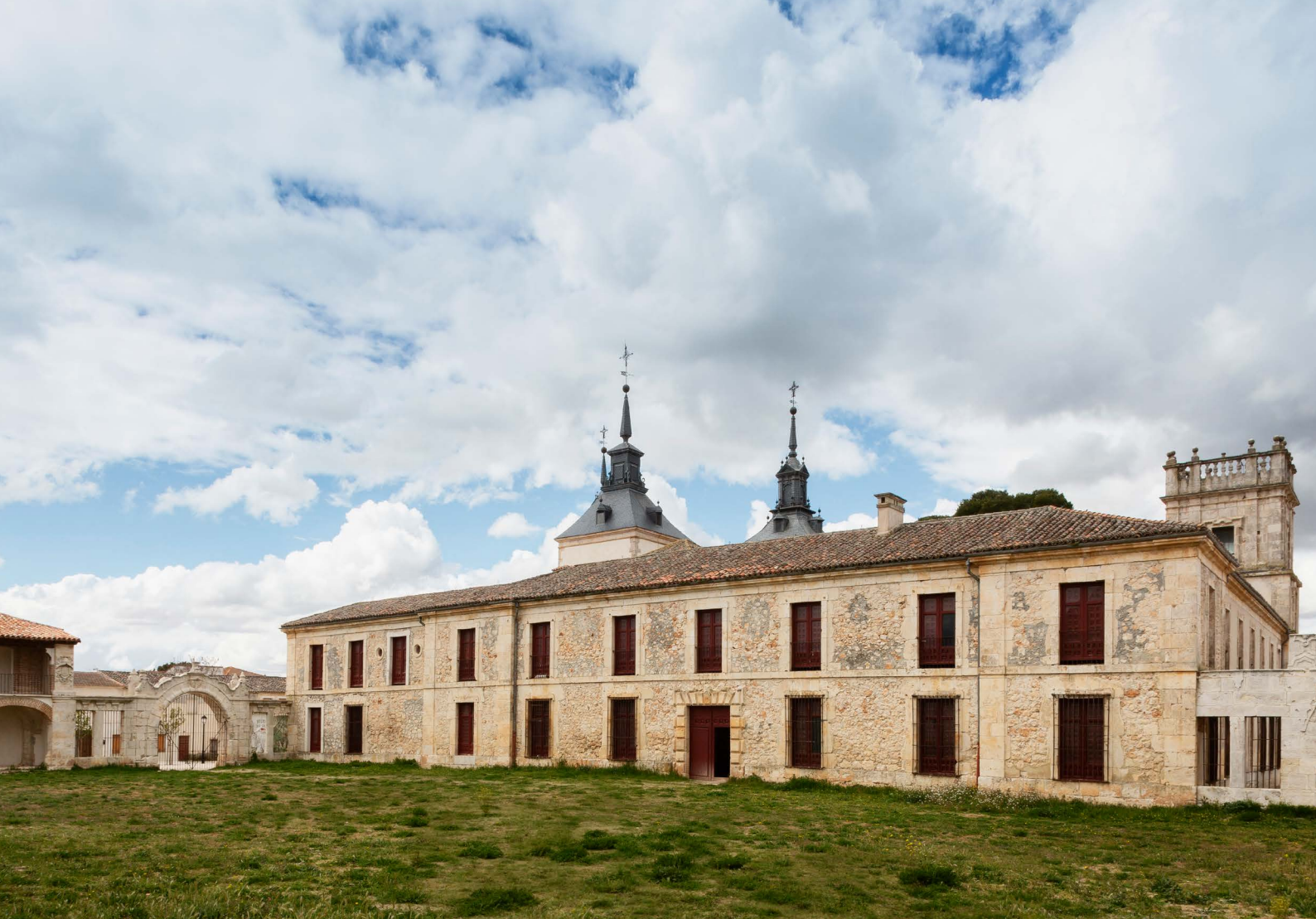
Palacio de Goyeneche, Nuevo Baztán
